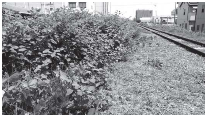
写真1 鉄道施工基面へのイタドリの侵入 （写真提供：小林孝義氏）
