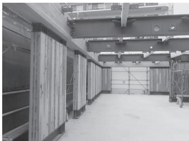
写真6 CLTが使われた奈良ぷろぼのビル
