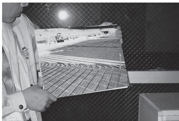
写真4 アンダーヒーティング用パイプの敷設状況
