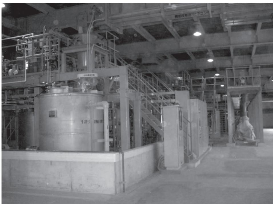
写真2 日本で最初に実用化された下水汚泥焼却灰からのリン酸回収プラント（岐阜市）
